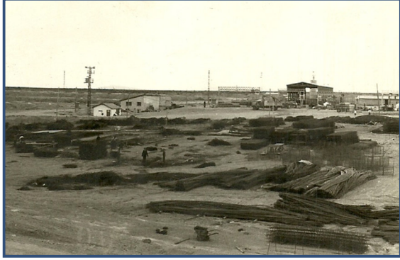
Şantiyenin kurulması ve ilk inşaat işleri, 1976
