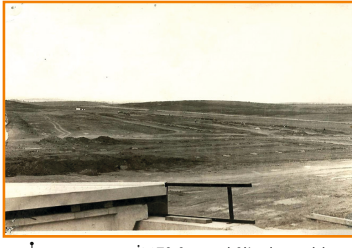
İMES Sanayi Sitesi arazisi ve Dudullu - Bostancı yolu, 1975
